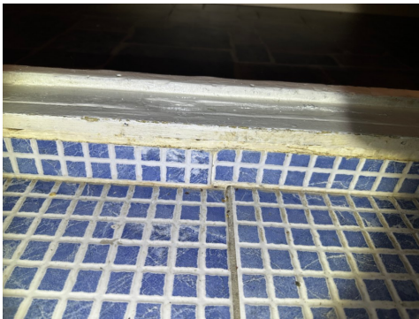
Overgang mot dørterskel.
