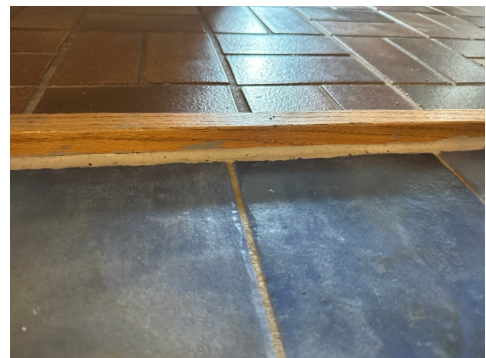
Overgang mot dørterskel.
