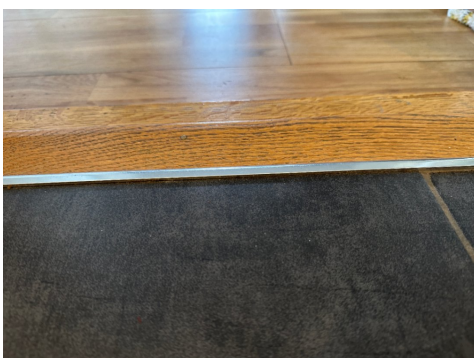
Overgang mot dørterskel.
