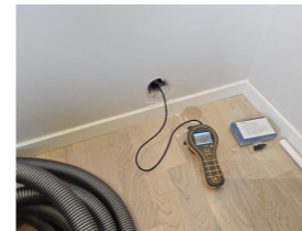
Utført kontroll i tiliggende konstruksjon - .
