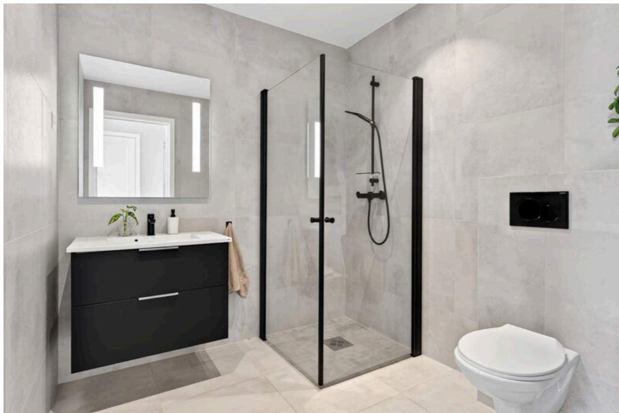
Bad m/dusjhjørne, baderomsinnredning m/speil og integrert lys, og vegghengt toalett i 2. etasje
