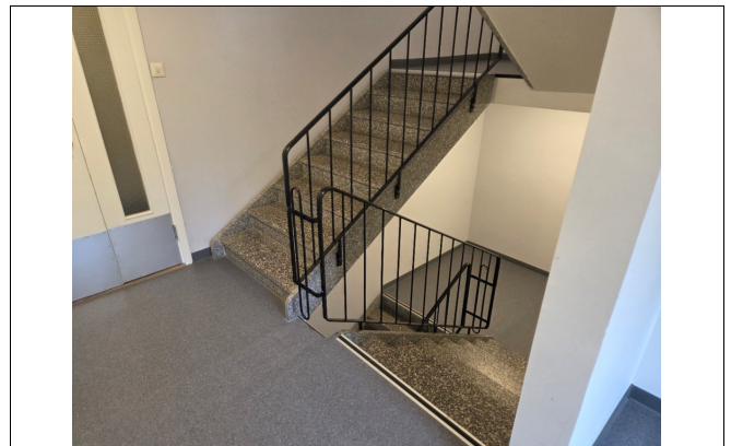
Felles trapperom med adkomst til etasjene.
