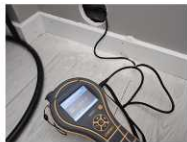
Utført kontroll i tiliggende konstruksjon - Fuktmåling bad 2. etg.
