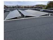
Tekking (med tilhørende beslag) - Taktekking
