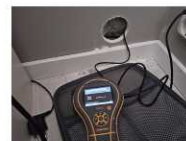
Utført kontroll i tilleggende konstruksjon - Fuktmåling bad 1. etg.
