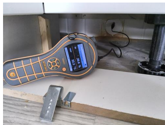
Utført kontroll i tilliggende konstruksjon - Fuktmåling
