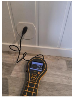
Utført kontroll i tilliggende konstruksjon - Fuktmåling
