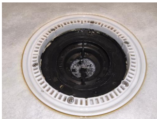
Tettesjiktets tilslutning til sluk - Sluk
