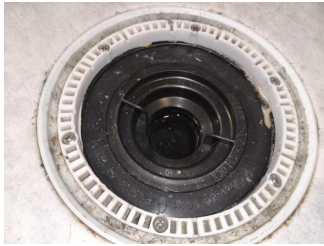
Tettesjiktets tilslutning til sluk - Sluk
