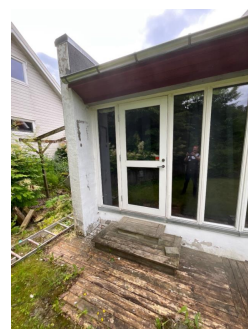
Ytterdører på baksiden av boligen
