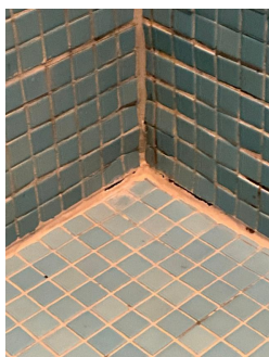
Sprekk i fugemasse og kanting av flis
