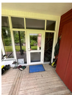
Ytterdører på baksiden av boligen
