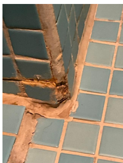
Sprekk i fugemasse og kanting av flis
