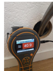
Kontroll i lukkede konstruksjoner - Fuktmåling i utlekket vegg mot terreng.
