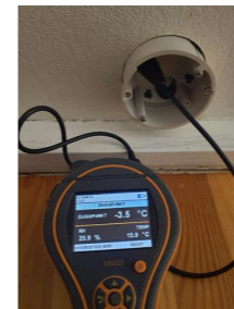
Utført kontroll i tilliggende konstruksjon - Fuktmåling.
