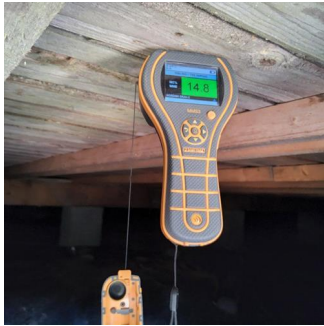
Helhetsvurdering - Eksempel på fuktmåling i krypkjeller
