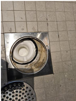
Tettesjiktets tilslutning til sluk - Sluk dusjsone bad 2.
