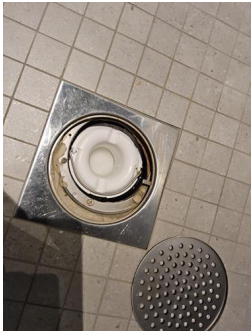
Tettesjiktets tilslutning til sluk - Sluk dusjsone bad 1.
