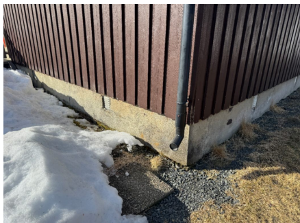
Takvann ført direkte ut på terreng
