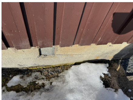
Sprekk i overflater av grunnmur
