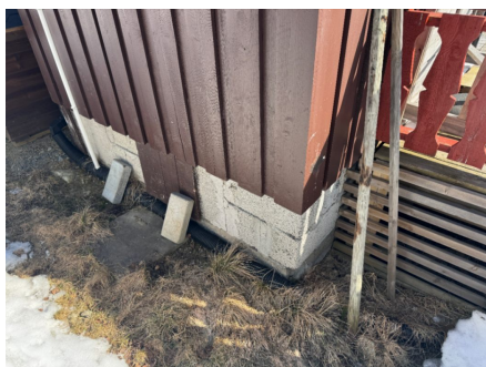
Sprekk i overflater av grunnmur
