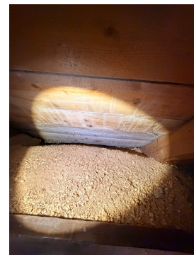
Loftet er isolert med flis, og det er ikke etablert lufting i skråtakskonstruksjonene.
