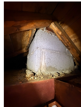
Pipe er innkledd med lettklinkerblokker på loft.
