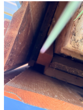
Yttervegger er utført uten lufting.
