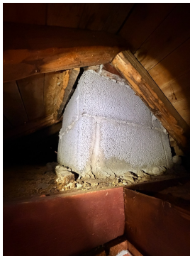
Pipen er innkledd med lettklinkerblokker på kaldtloft.
