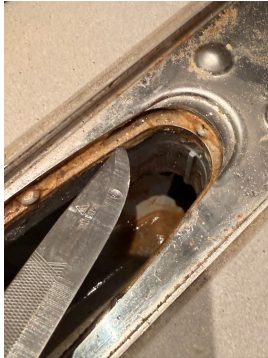
Synlig membran under klemring i sluk.
