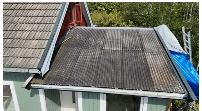
Takteking på tilbygg.
