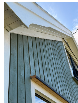
Yttervegger er utført uten lufting.
