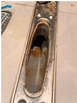
Synlig membran under klemring i sluk.
