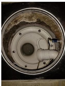
Tettesjiktets tilslutning til sluk - Sluk bad
