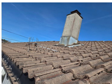
Ligg løs antenne på taket
