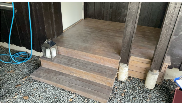
Hovedinngang med trapp og plattning av impregnerte materialer. Plattning ca. 2,7 m 2 .
