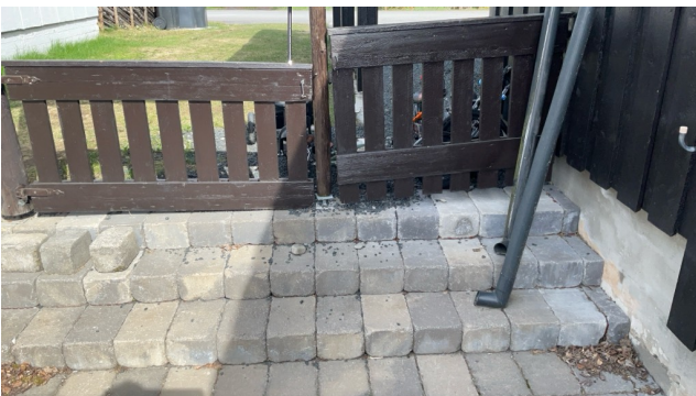
Utvendig trapp og terrasseetting på ca. 13 m 2 .
