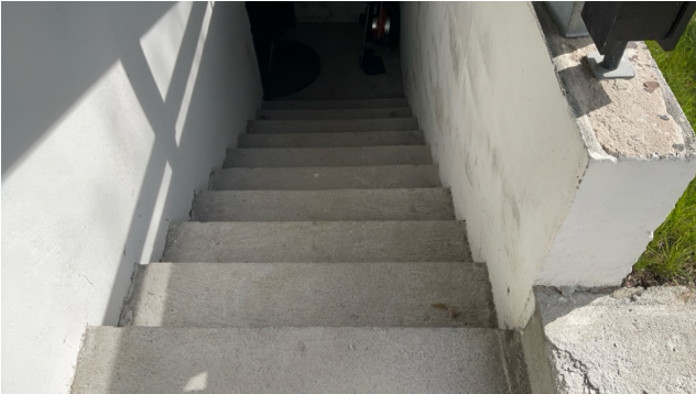
Utvendig overbygget kjellernedgang med betongtrapp til utleiedel.
