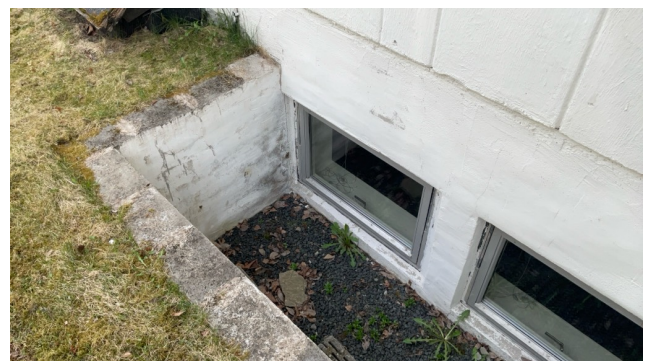
Firstøtning ved kjelervinduer.
