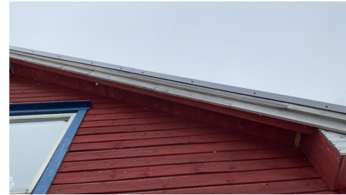
Værslitasje, brukt flere korte bord
