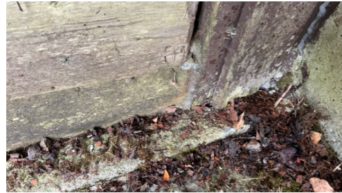
Fukt/råteskadd kjellerdør
