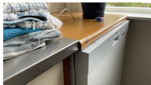
Overgang mot oppvaskmaskin
