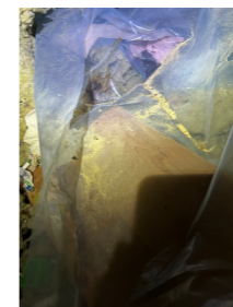
Fuktmerke, ikke utslag for fukt
