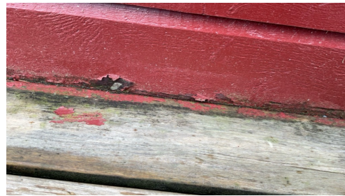
Veranda ved inngang
