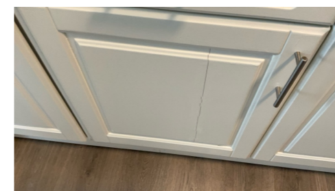
Sprekk i front
