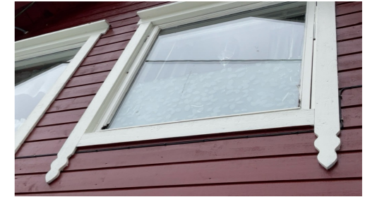
Fukt/råteskadd vindu
