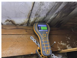
Synlige overflater (taktro, vegger, gulv, o.l.) - Fuktmåling
