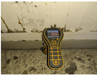
Utført kontroll i tilliggende konstruksjon - Fuktmåling
