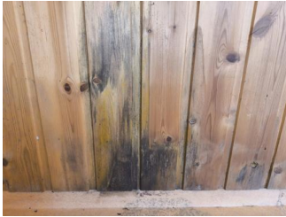
Overflater vegger - Muggsopp på veggflater
