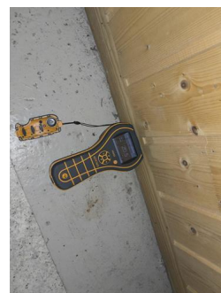
Kontroll i lukkede konstruksjoner - Fuktmåling i yttervegg
