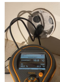
Utført kontroll i tiliggende konstruksjon - Fuktmåling.
