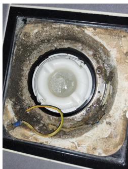
Tettesjiktets tilslutning til sluk - Sluk
