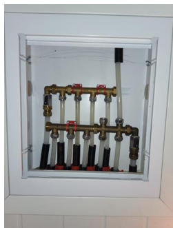
Vannrør - Fordelerskap
