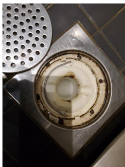
Tettesjiktets tilslutning til sluk - Sluk
