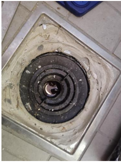
Vanntett sjikt / membran - Sluk i teknisk rom.
