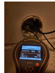
Utført kontroll i tilliggende konstruksjon - Fuktmåling.
