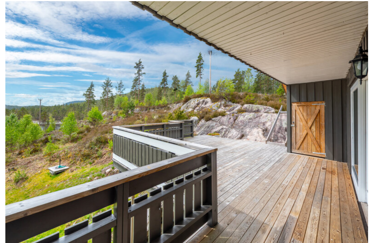
Romslig uteplass med delvis overbygg som gir le og fleksibelt bruk.
