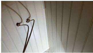
List mangler i hjørnet fra midten av veggen og ned
