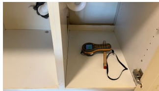
Ingen fuktindikasjon registrert ved fuktsøk
