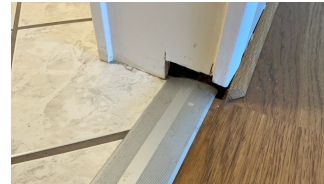
Stor åpning i foring mot gulv
