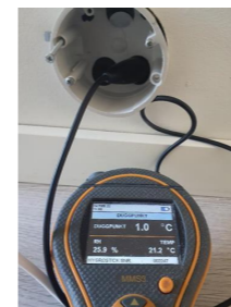
Utført kontroll i tiliggende konstruksjon - Fuktmåling.
