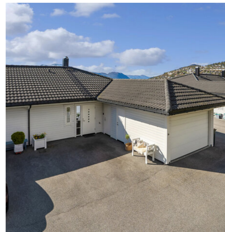
Romsleg asfaltert gardstun og garasje
