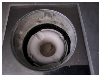
Tettesjiktets tilslutning til sluk - Sluk
