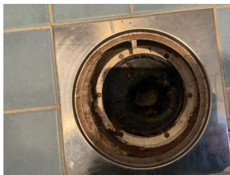
Sluk i dusj nisje med bane membran under klemring
