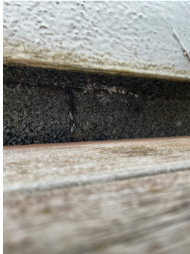
Undertekking av papp med oppbrett
