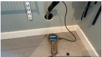
Ingen fuktutslag registrert ved fuktmåling i vegg
