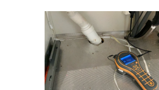
Ingen fuktindikasjon registrert ved måling med pinner
