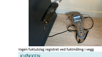
Ingen fuktutslag registrert ved fuktmåling i vegg
