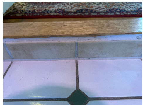
Overgang mot dørterskel.
