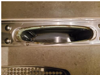
Tettesjiktets tilslutning til sluk - Sluk i dusjsonen.
