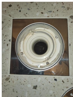
Tettesjiktets tilslutning til sluk - Sluk i dusjsonen
