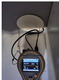
Utført kontroll i tilliggende konstruksjon - Fuktmåling
