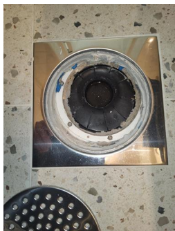
Tettesjiktets tilslutning til sluk - Sluk utenfor dusjsonen
