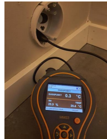
Utført kontroll i tiliggende konstruksjon - Fuktmåling.
