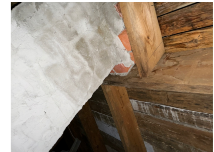
Eldre fuktskjolder loft.
