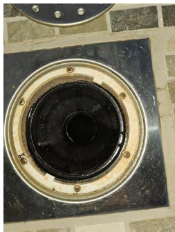
Tettesjiktets tilslutning til sluk - Sluk bad
