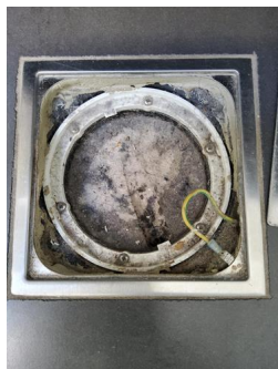
Tettesjiktets tilslutning til sluk - Hjelpesluk utenfor dusjsonen.
