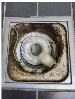
Tettesjiktets tilslutning til sluk - Hovedsluk i dusjsonen.
