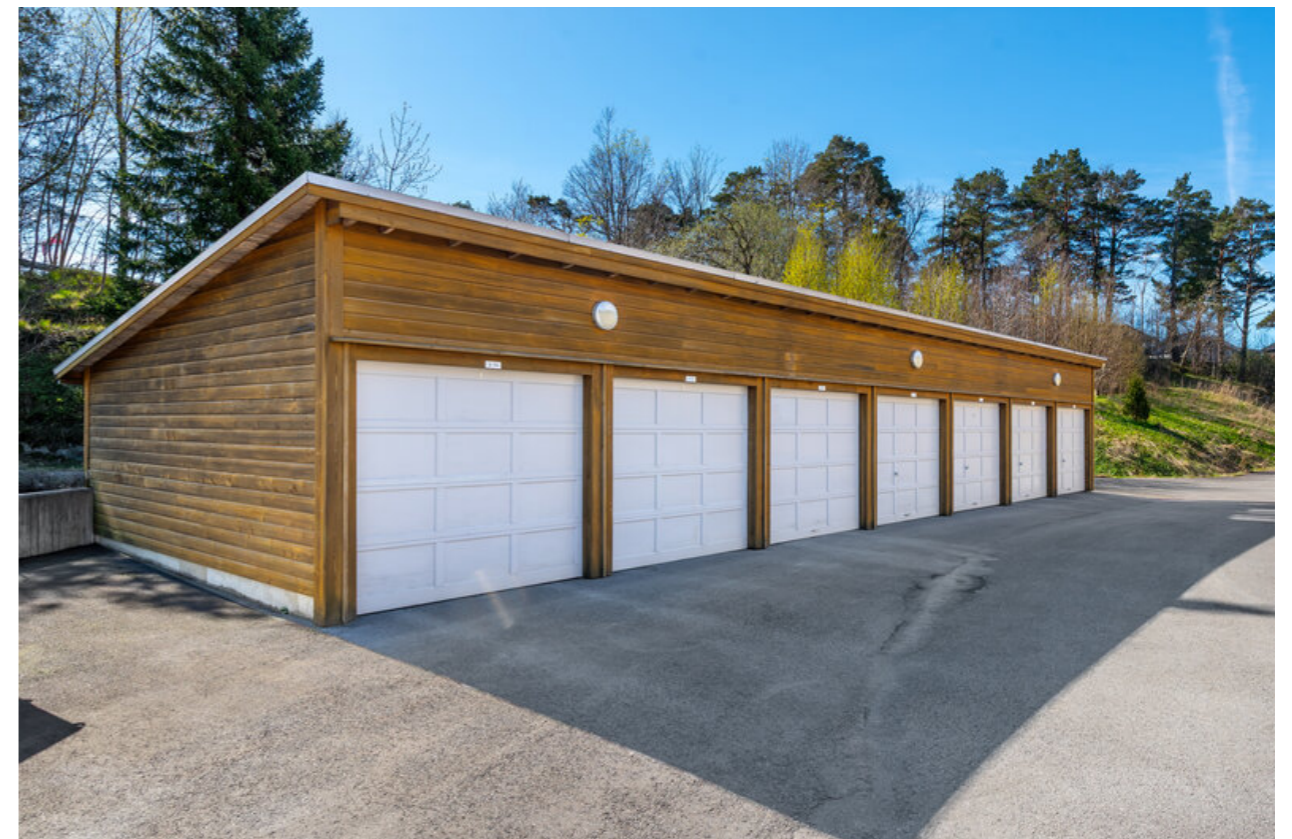
Egen garasje i rekke med elbil-lader montert.
