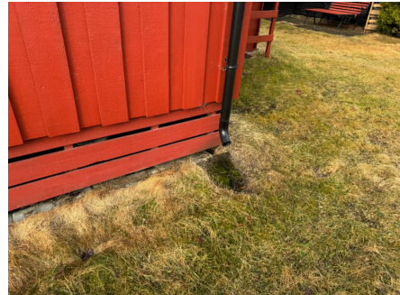
Takvann ført direkte ut på terreng
