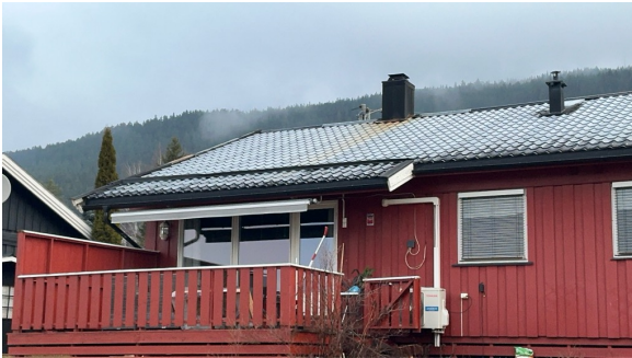
Avflassing på takplater
