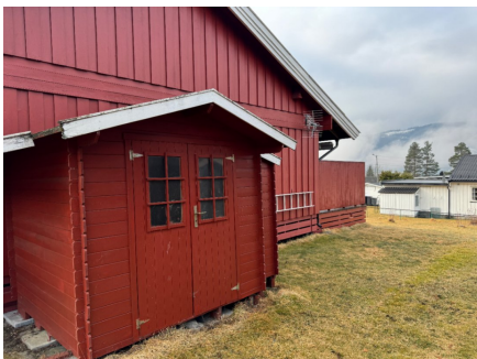
Oversiktsbilde av bod som er oppført på kortsiden av bygget
