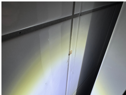
Hull etter tidligere dusjvegger
