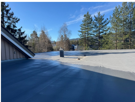
Taktekking på tilbygget del
