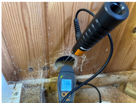
Fuktmålinger i utforede kjellervegger
