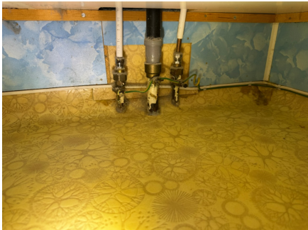
Utett under vask som er en del av våtsone på badet
