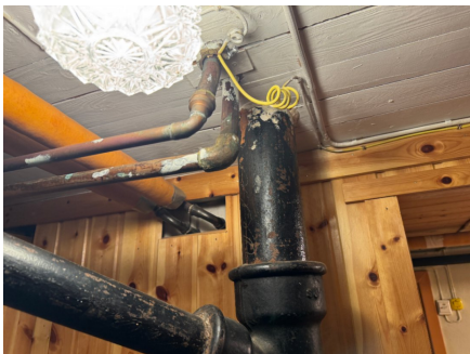
Støpejernsrør i kjeller
