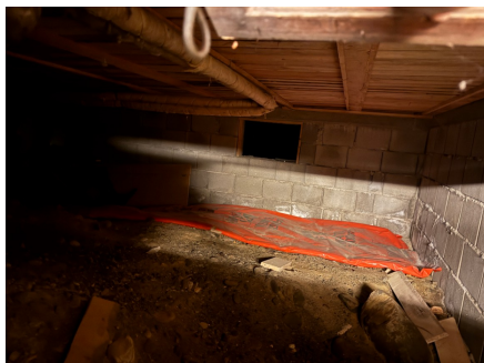
Bilde av kryptjeller fra vindu i kjellerrom
