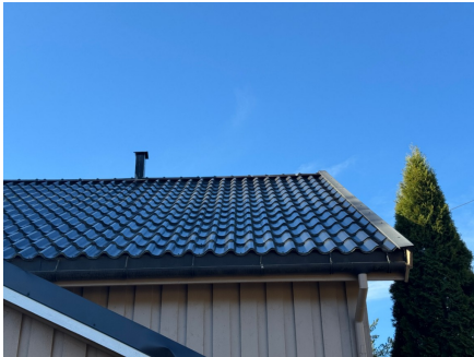
Taktekking på opprinnelig del
