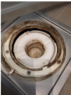
Tettesjiktets tilslutning til sluk - Sluk i dusjsonen.
