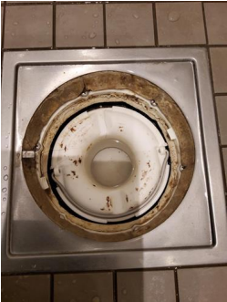
Tettesjiktets tilslutning til sluk - Sluk i dusjsjonen.
