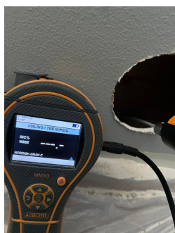
Fuktmåling mot våtsone bak dusj
