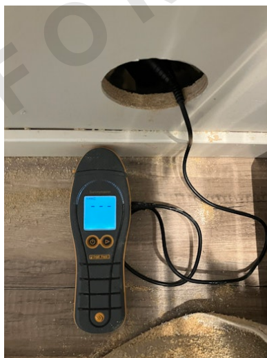
Bilde av fuktsøk uten at det påvises unormale forhold.
