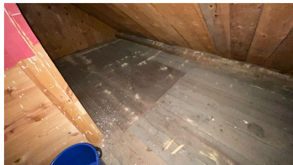
Synlig aktivitet etter stripe borebille i kott
