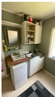
Mangler fuge/kantlist på benkeplate ved vask
