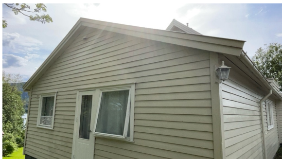
Luftespalte er synlig i raftekasse
