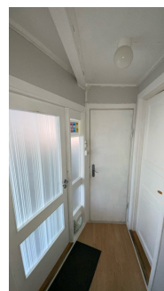
Dører i 2. etasje til felles gang, bad og soverom sett fra gang i leiligheten.
