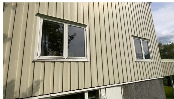
Vinduer fra 2006 i gavelvegg
