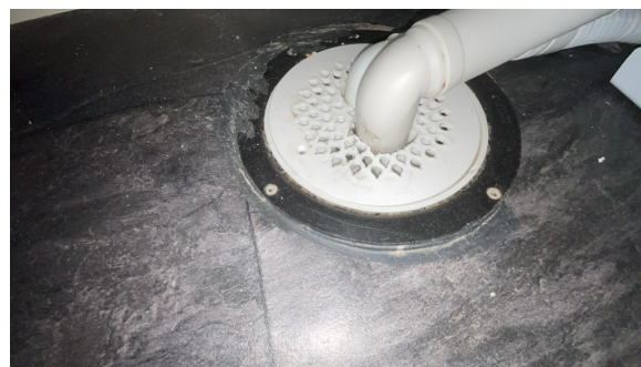
Belegg er ikke montert riktig ved sluk
