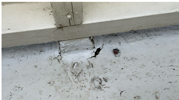
Skader i overflate på dekke ved rekkverk
