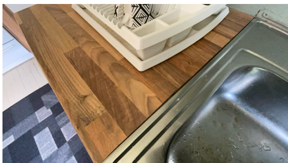
Mangler fuge/kantlist på benkeplate ved vask
