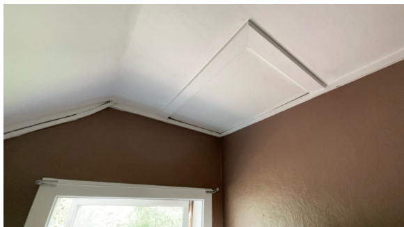
Uisolert loftsluke
