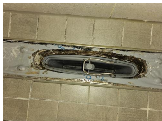
Tettesjiktets tilslutning til sluk - Sluk dusj
