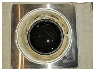
Tettesjiktets tilslutning til sluk - Sluk bad
