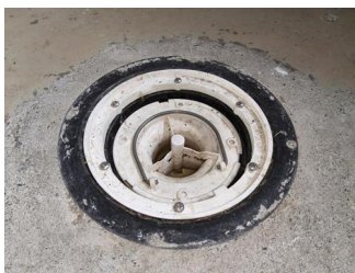
Avløpsrør (inkludert sluk) - Sluk
