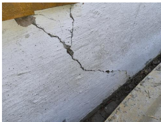
Fundament, grunnmur og gulv mot grunn - Sprekk i grunnmur
