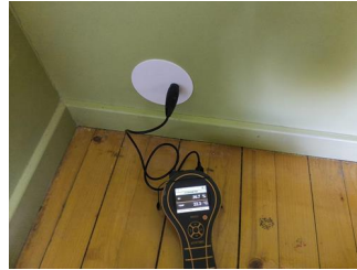
Utført kontroll i tillegg til konstruksjon - Fuktmåling
