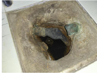
Tettesjiktets tilslutning til sluk - Sluk
