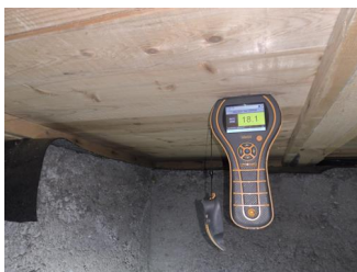
Stikktaking i treverk, fukt og fuktmålinger - Fuktmåling
