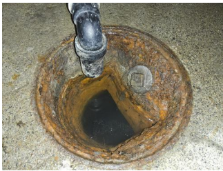
Tettesjiktets tilslutning til sluk - Sluk
