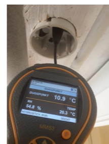
Utført kontroll i tiliggende konstruksjon - Fuktmåling.
