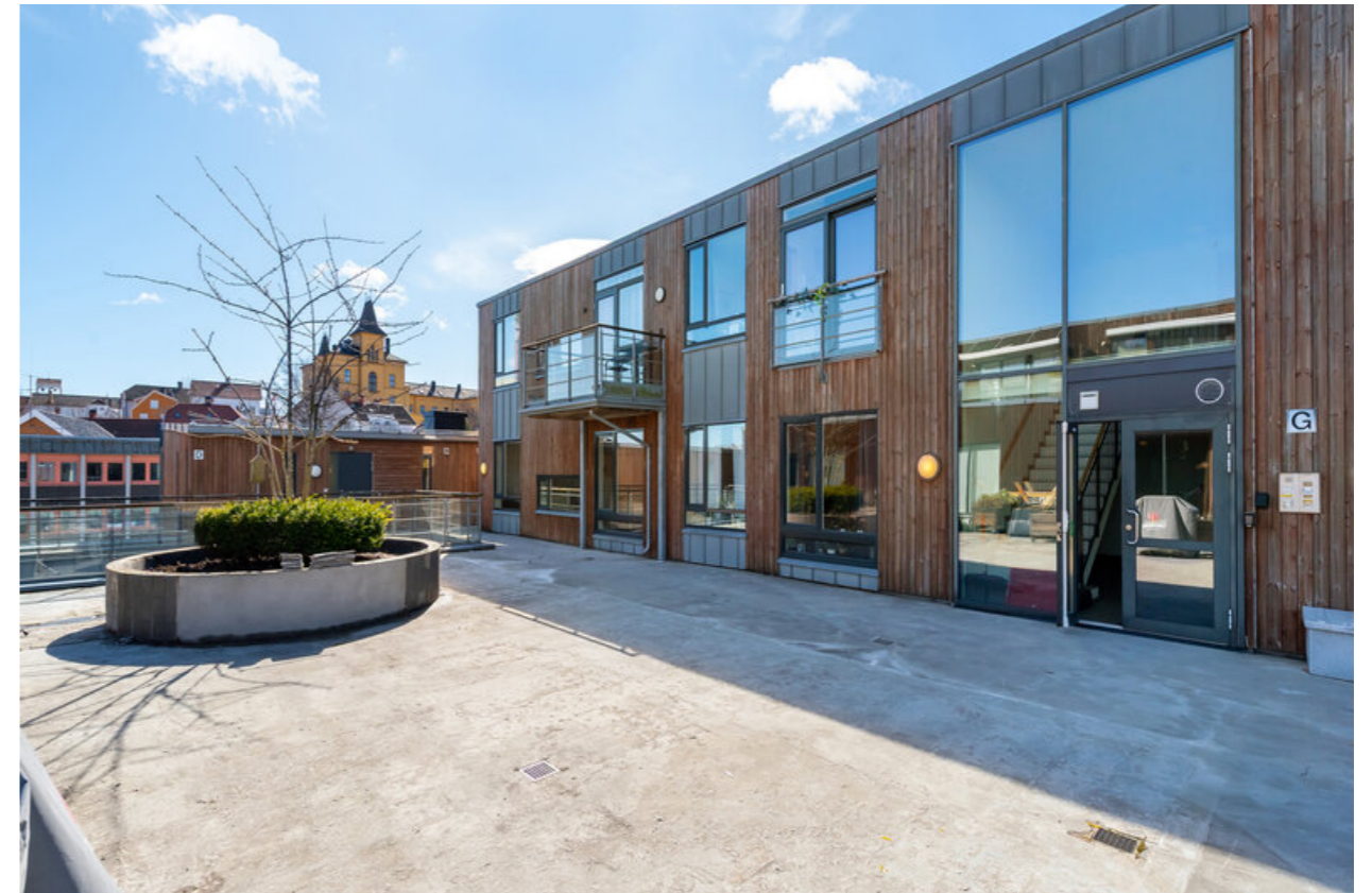
Inngang til leilighetsbygg 7G.
