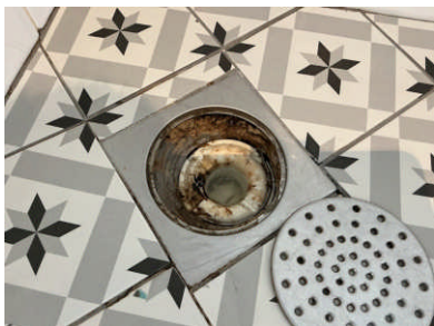
Bilde av sluk.
