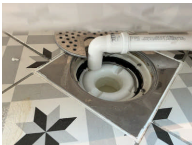
Bilde av sluk
