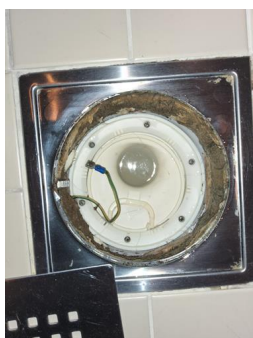
Tettesjiktets tilslutning til sluk - Sluk bad
