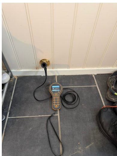
Fuktmåling bak tettesjikt.
