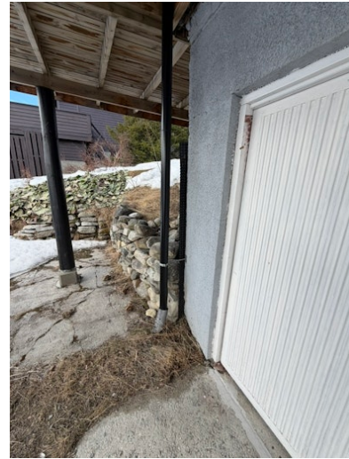
Taknedløp ført ned i rør i bakken.
